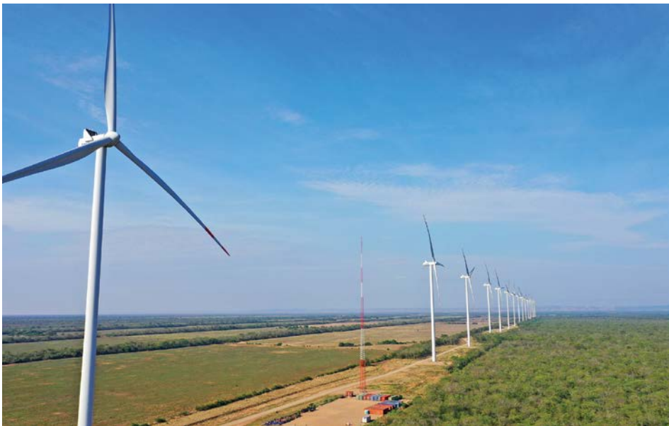
Parque Eólico El Dorado de ENDE Corporación, ubicado en Santa Cruz, con 54 MW de capacidad instalada.
